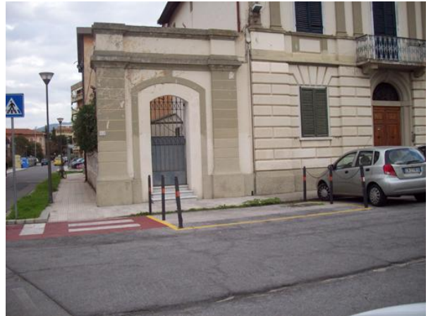
Area protetta INUTILIZZATA in piazza davanti alla Chiesa di San Michele degli Scalzi (notare che leva il posto per il parcheggio di una o due automobili)
