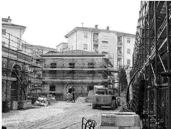
Il cantiere dei lavori alle ex Stallette
