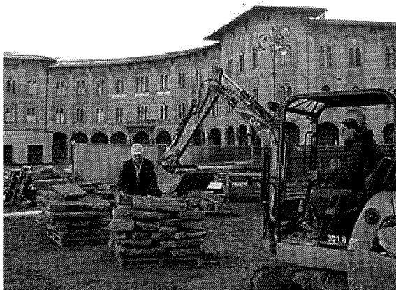
TORMENTONE Una foto di piazza Vittorio quando era ancora allestito il cantiere per il park sotterraneo
