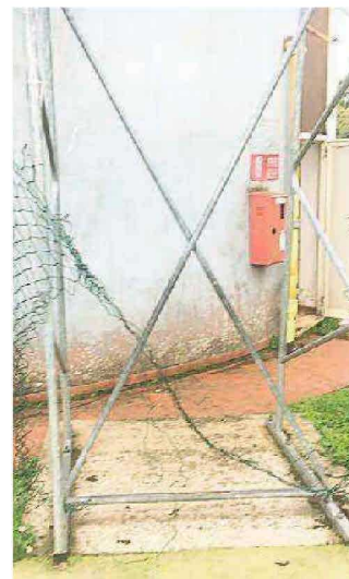
Una recinzione da riparare
