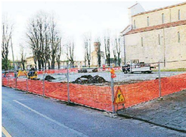
I lavori in piazza San Paolo a Ripa d'Arno
