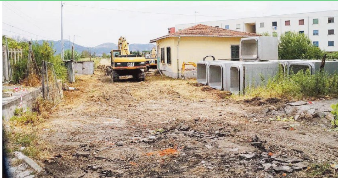
Ruspa al lavoro nel cantiere, a destra gli scatoletti che dovranno permettere un migliore deflusso delle acque
