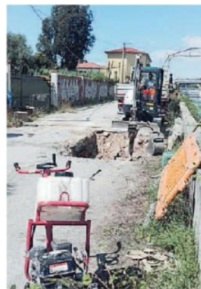
I lavori a Porta a Mare
