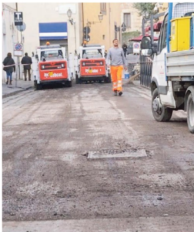
L'asfaltatura di una strada
