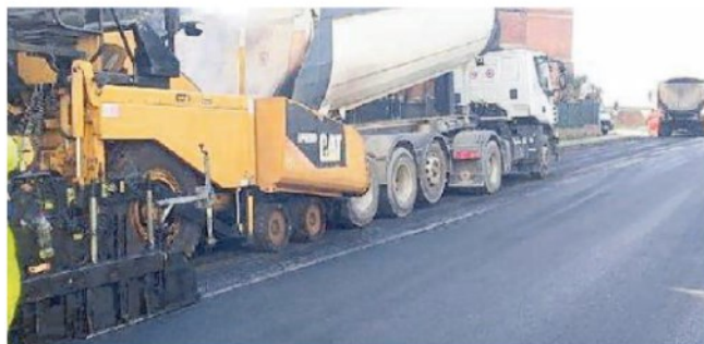
Mezzi al lavoro in via di Balduccio
