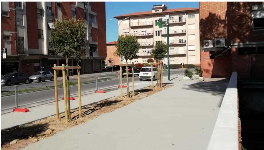
I lavori effettuati al Cep
