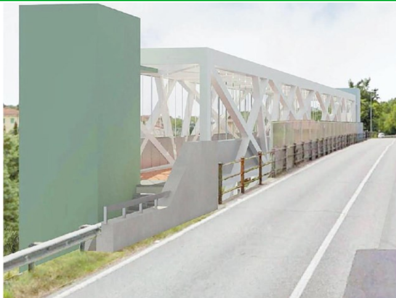
L'ampliamento della passerella a fianco dell'attuale cavalcavia
