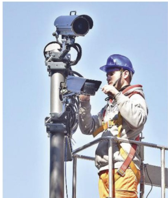
Il montaggio di una telecamera di videosorveglianza (la foto è di repertorio)
