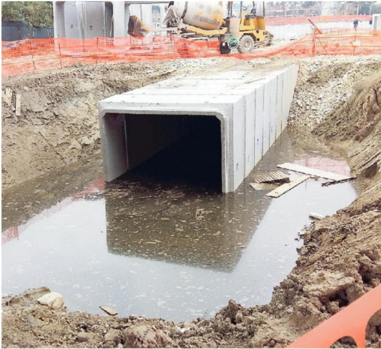
Uno degli scatolari fognari installati con il cantiere del People Mover e, a destra, l'assessore Raffaele Latrofi.
