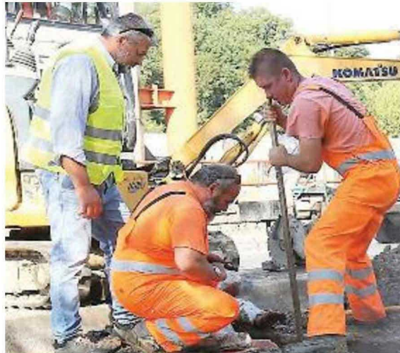
CANTIERE I lavori all'acquedotto sono previsti per il 10 agosto: quel giorno città senz'acqua
