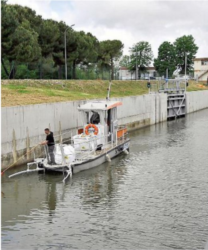
LAVORI DURATI 14 ANNI Il canale dei Navicelli e l'Incile
