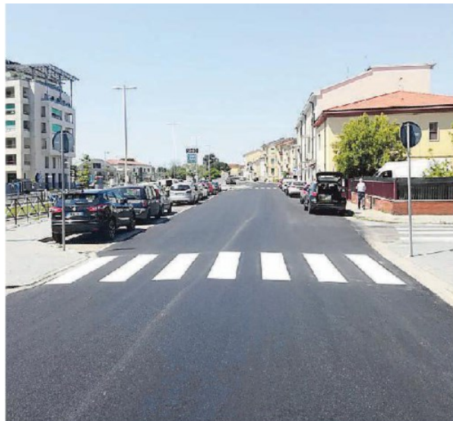
Un tratto riasfaltato in via Livornese
