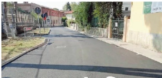
L'asfaltatura di via Baldacci
