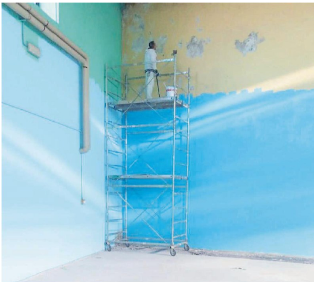
I lavori all'interno della palestra ieri mattina
