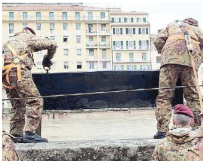
Il montaggio delle paratie sui lungarni
