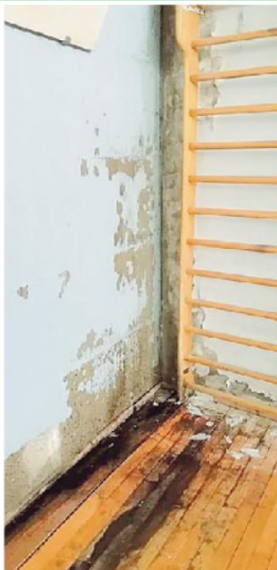
SAN MARCO , SI REGISTRANO PROBLEMI DI INFILTRAZIONI DI ACQUA DALLE COPERTURE DELLA STRUTTURA
