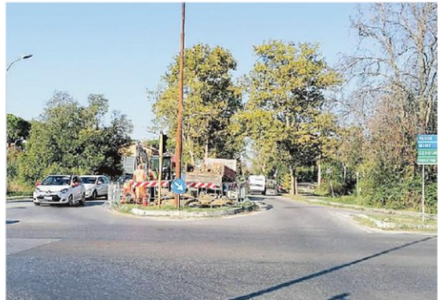
L'allestimento del cantiere
