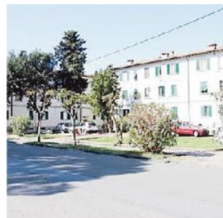
L'area interessata dai lavori
