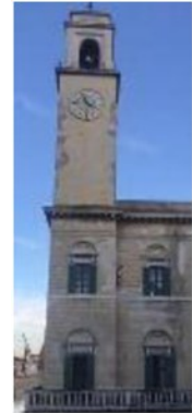
Uno scorcio di palazzo Pretorio: disco verde ai lavori di restauro dell'edificio, ricostruito nel 1953 dopo i bombardamenti
