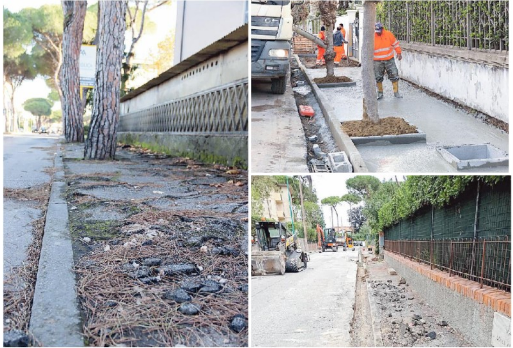
Sopra i marciapiedi in via di Pratale; a destra, dall'alto, un cantiere a Porta e Lucca e i lavori in corso a Tirrenia
