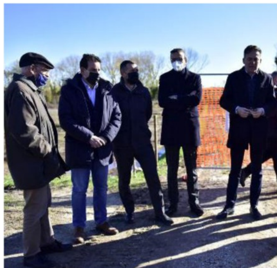
Dringoli, Latrofa, Milli, Mazzeo e Conti sul cantiere (Foto Cappello/Valtriani)
