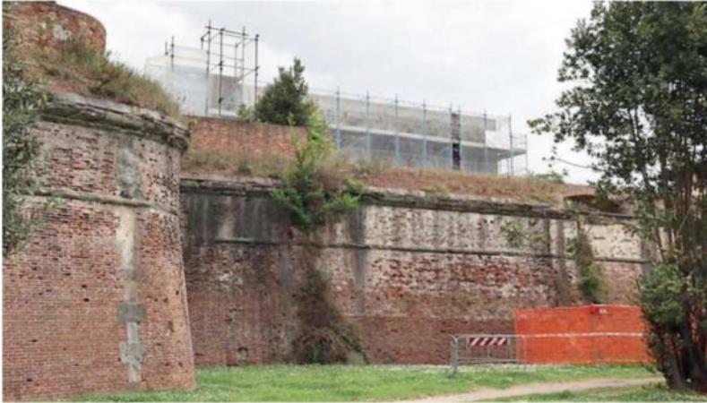
Ilavori al Bastione Sangallo
