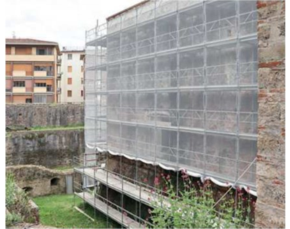
Un dettaglio del cantiere
