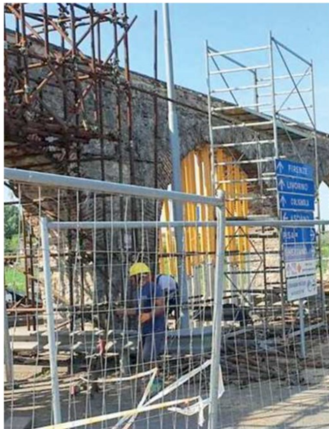
Il cantiere al passaggio sotto l'acquedotto
