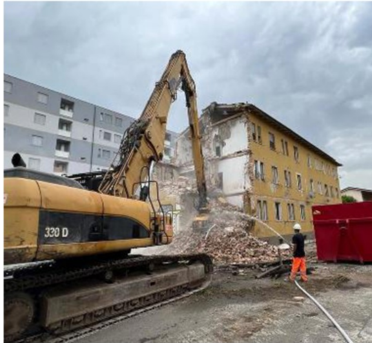
Un momento dell'operazione di demolizione delle palazzine Erp in Sant'Ermete
